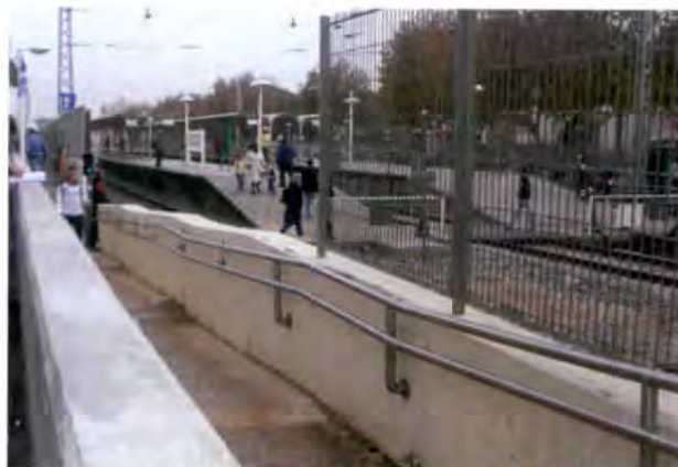
Atravessamento da linha ferroviária na estação de São Pedro do Estoril
