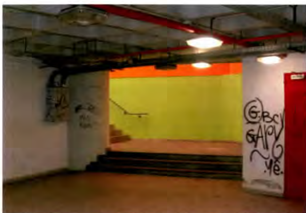
Ligação subterrânea entre a estação ferroviária e o terminal rodoviário
