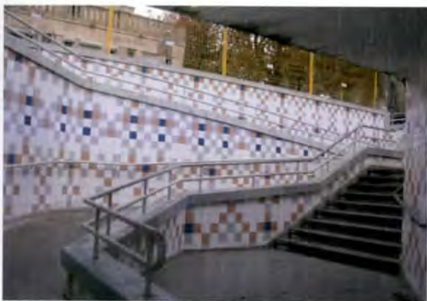
Acesso à passagem subterrânea da estação da Parede
