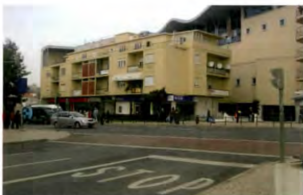
Ligação à superfície entre a estação ferroviária e o terminal rodoviário
