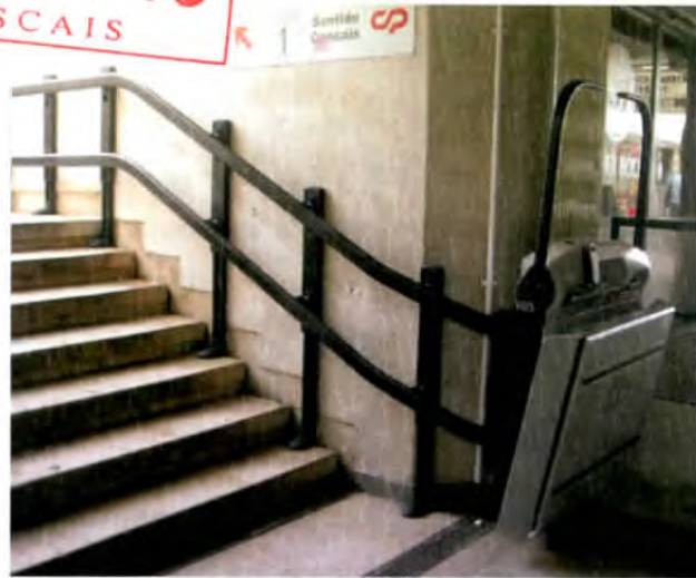
Sistema de apoio a cadeiras de rodas existente na interface do Estoril
