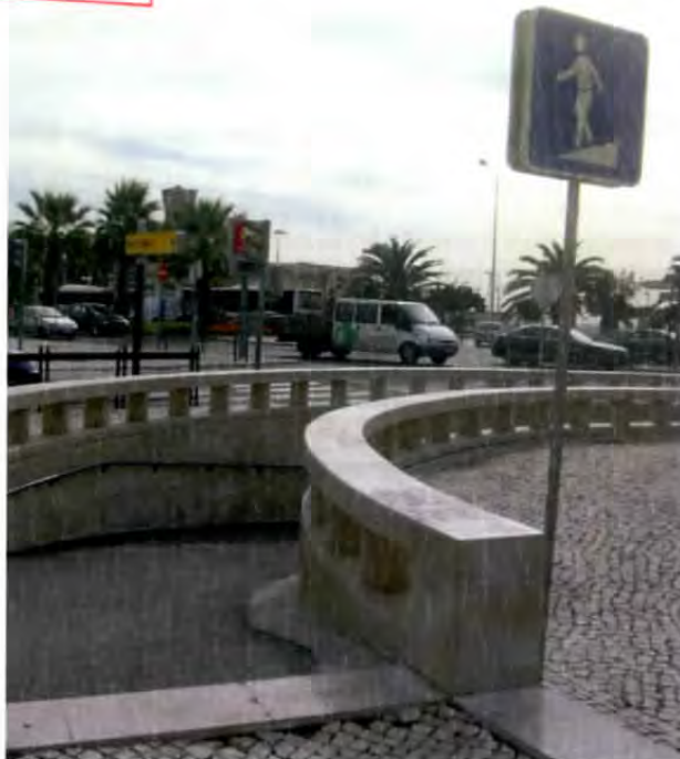
Passagens inferiores da estação do Estoril
