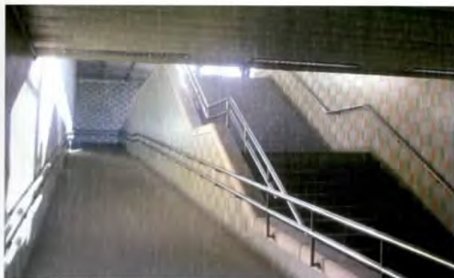
Passagens inferiores da estação de Carcavelos
