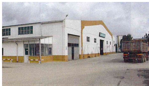
Detalhe do estado de conservao e limpeza dos pavimentos, junto  sada das Instalaes da JODOFER.
