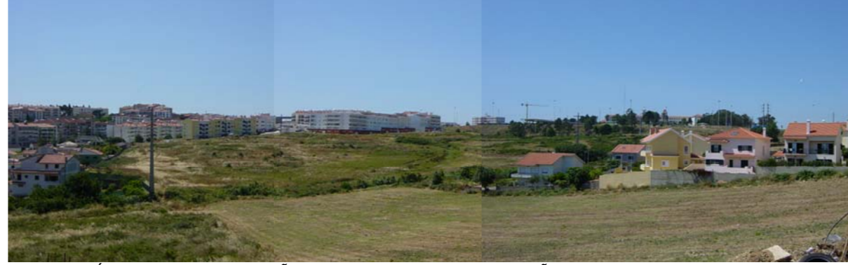
VISTA DA ÁREA DE INTERVENÇÃO PARA NORTE - LOCALIZAÇÃO Nº6
