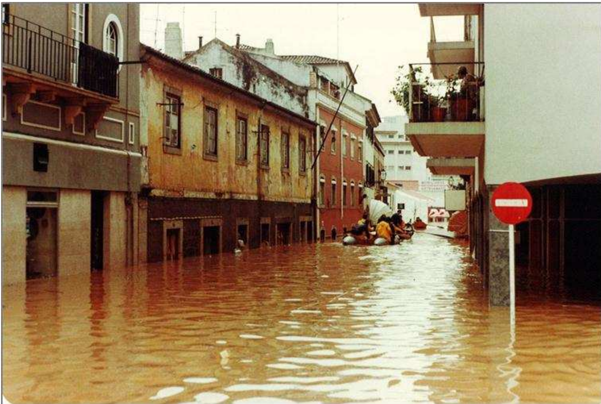
Figura 70 Cheias de 1983 na vila de Cascais
