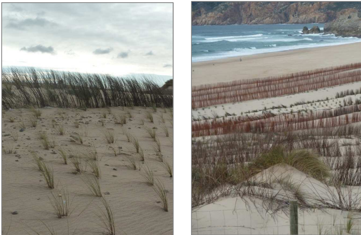
Figura 23 e 24 Estabilização do sistema dunar Guincho-Cresmina
