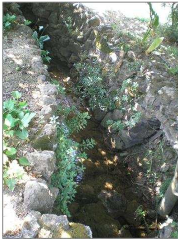
Figura 61 Muros de pedra
