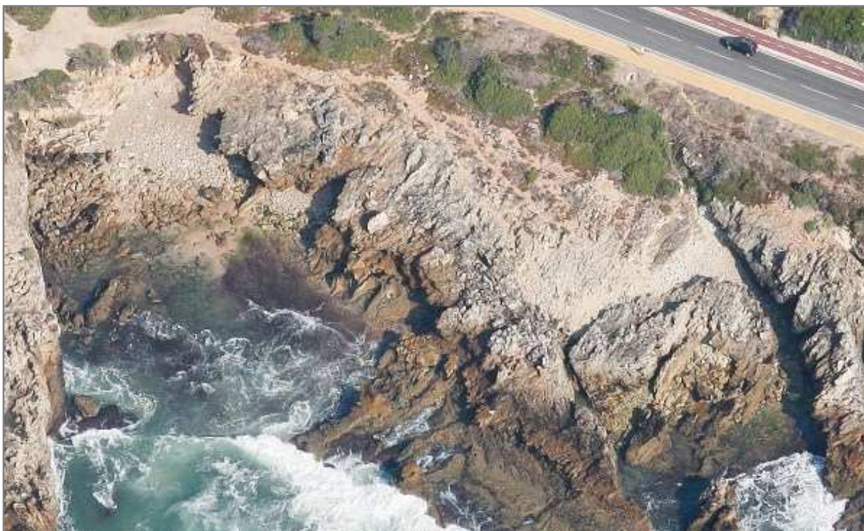
Figura 34 Instabilidade do tipo Desabamento
