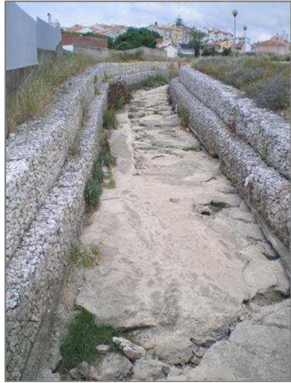
Figura 52 Muros de gabiões
