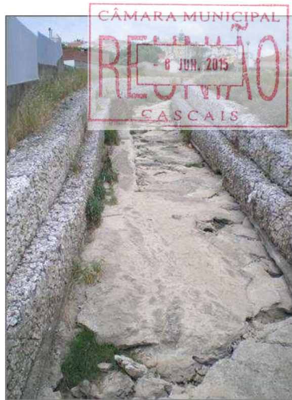
Figura 52 Muros de gabiões
