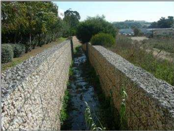
Figura 66 Secção com muros de gabiões
