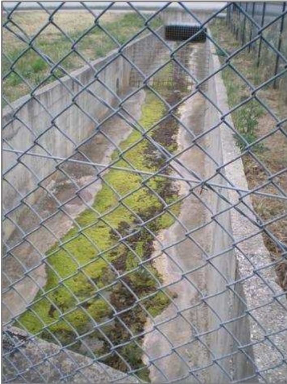
Figura 51 Troço canalizado no aeródromo de Tires
