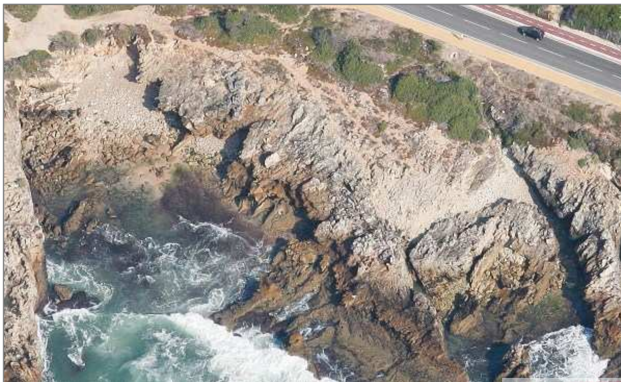
Figura 34 Instabilidade do tipo Desabamento
