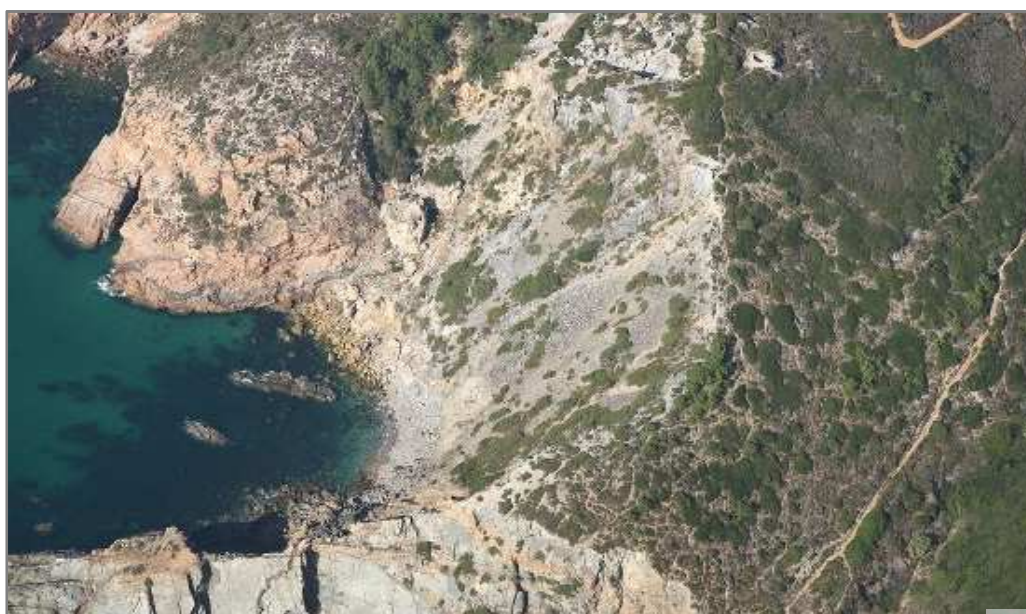
Figura 32 Instabilidade do tipo Escorregamento ou Deslizamento
