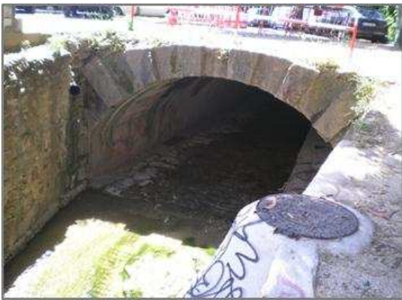
Figura 73 Troço canalizado junto ao mercado
