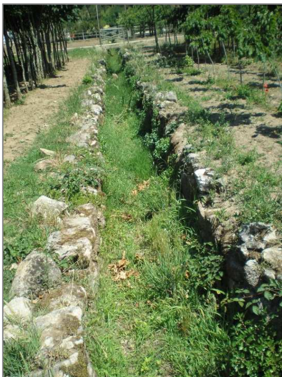
Figura 87 Leito da ribeira entre muros de pedra
