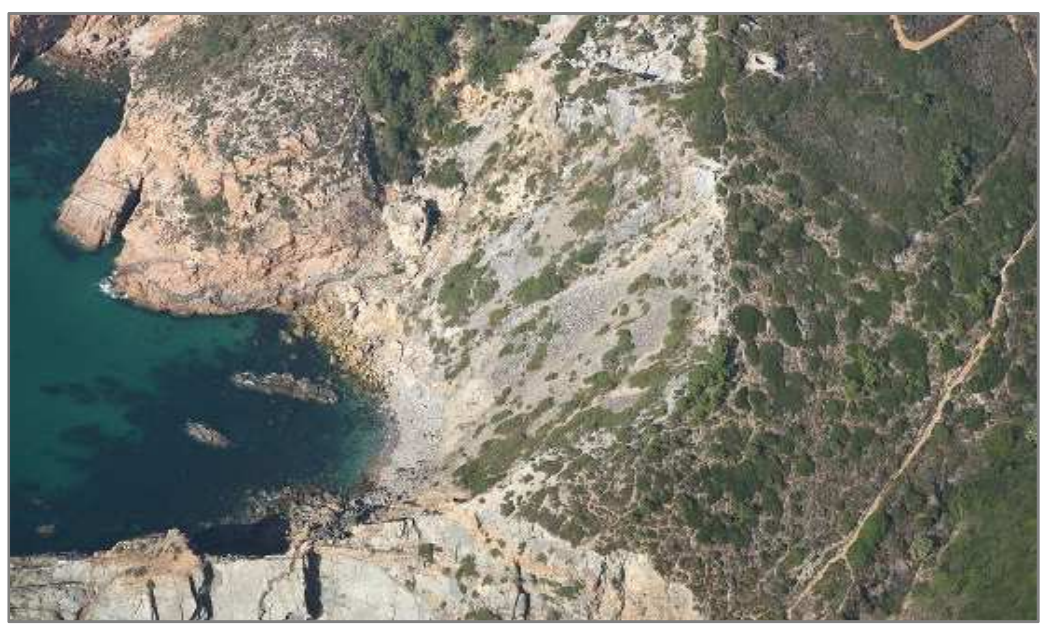
Figura 32 Instabilidade do tipo Escorregamento ou Deslizamento
