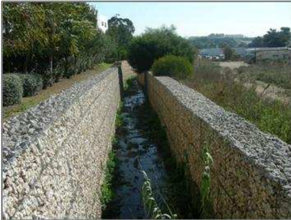
Figura 66 Secção com muros de gabiões
