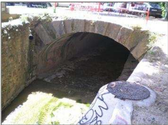
Figura 73 Troço canalizado junto ao mercado
