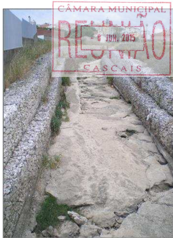
Figura 52 Muros de gabiões
