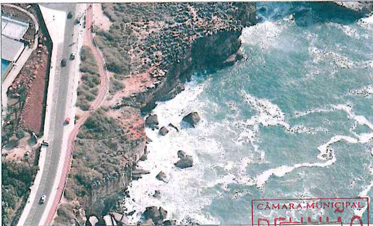
Figura 33 Instabilidade do tipo Tombamento ou Balançamento
