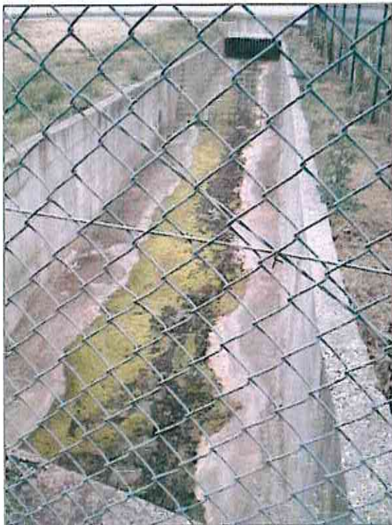
Figura 51 Troço canalizado no aeródromo de Tires
