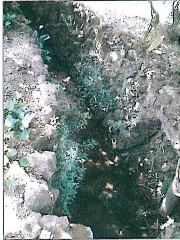
Figura 61 Muros de pedra
