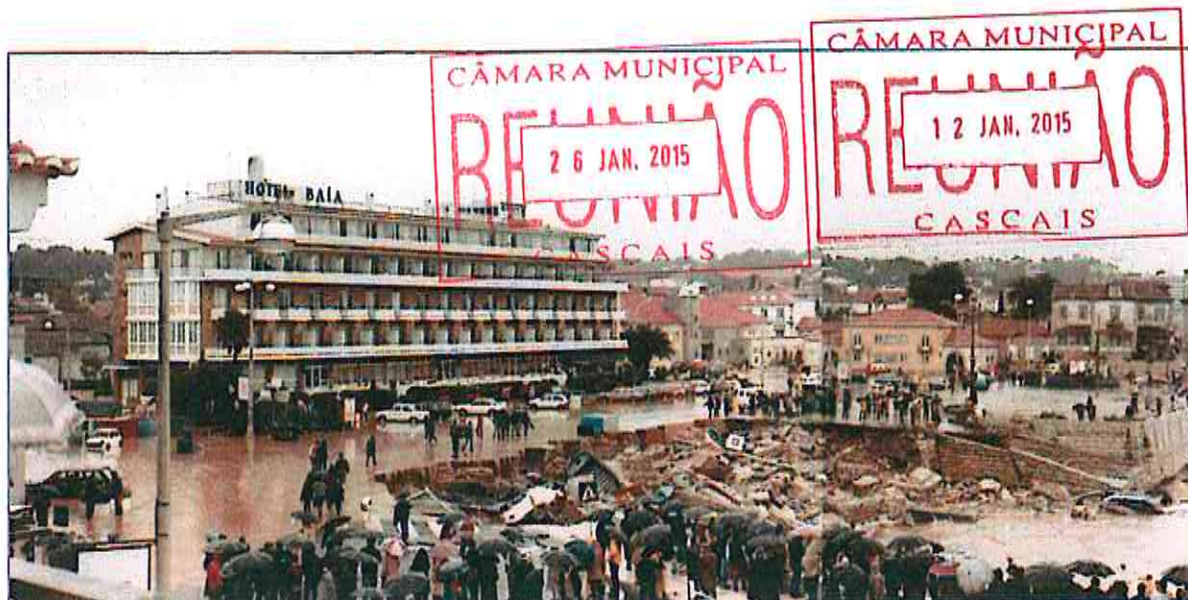
Figura 117 Cheias de 19 de novembro de 1983 em Cascais junto à prala da Ribeira
