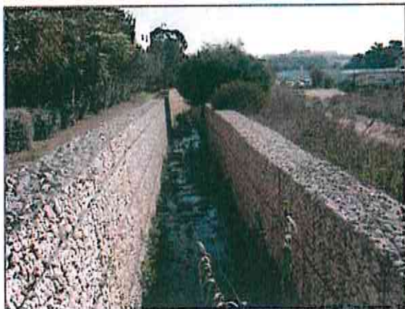
Figura 66 Secção com muros de gabiões
