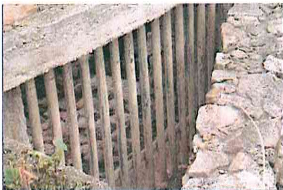
Figura 79 Estrangulamentos de secção em Birre
