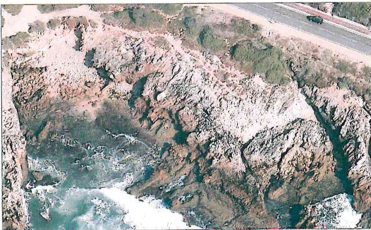
Figura 34 Instabilidade do tipo Desabamento
