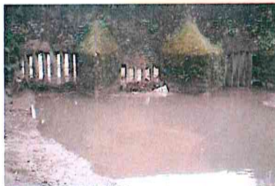
Figura 80 Estrangulamentos de secção junto à foz
