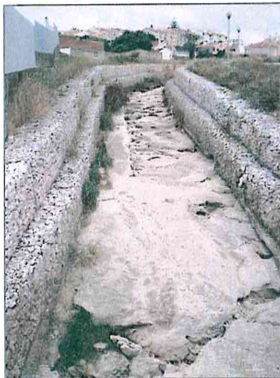
Figura 52 Muros de gabiões
