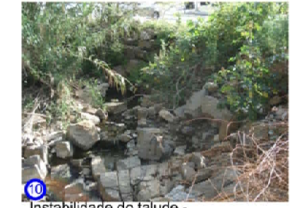
10 Instabilidade do talude - margem esquerda
