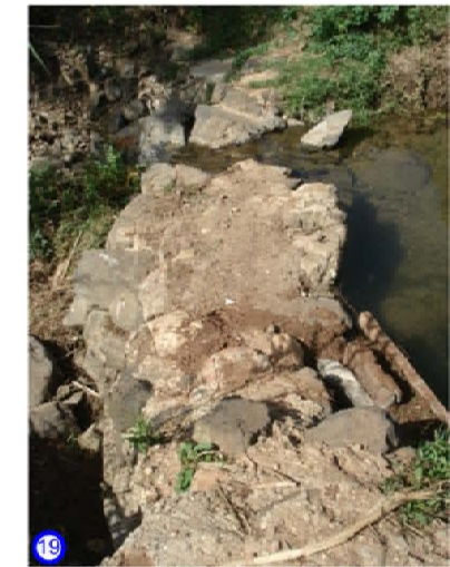
19 Pormenor do actual represamento
