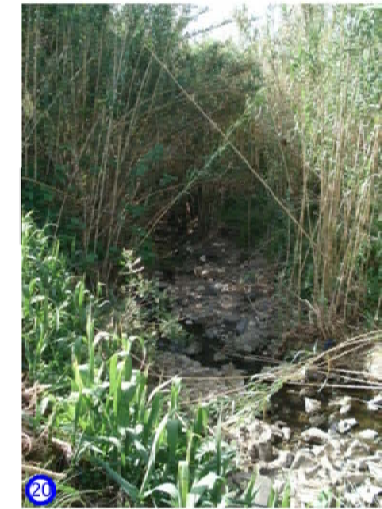
20 Vista para jusante (caniçais)
