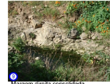
9 Margem direita consolidada
