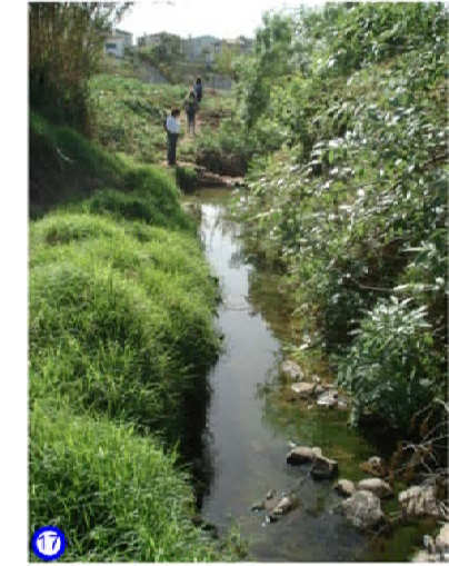
17 Vista para jusante (represamento)
