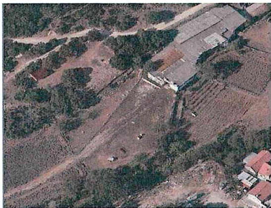
Figura 77 Secção entre muros na Atrozela
