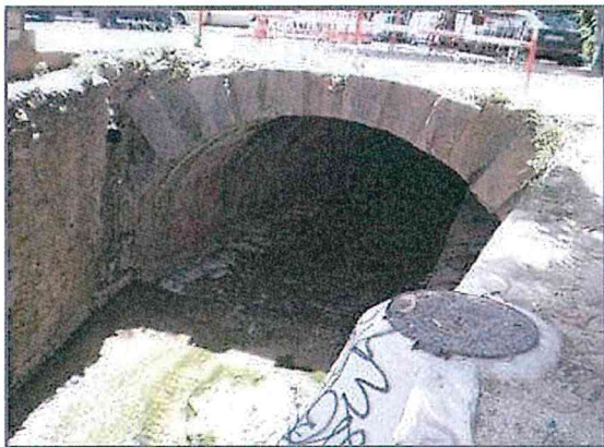
Figura 73 Troço canalizado junto ao mercado
