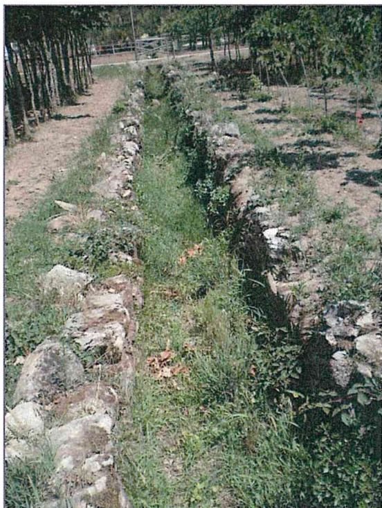
Figura 87 Leito da ribeira entre muros de pedra
