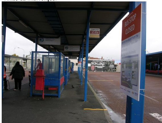
Antes da intervenção:
