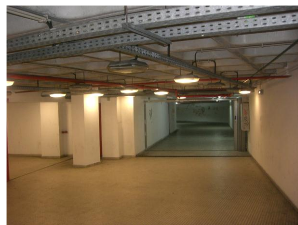
Interface de Cascais: Fundamental melhorar a atractividade e agradabilidade da passagem pedonal subterrânea
