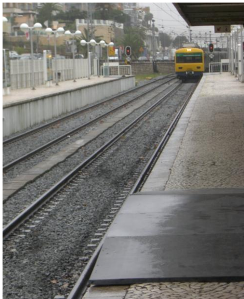
Plataforma de acesso nas estações CP
