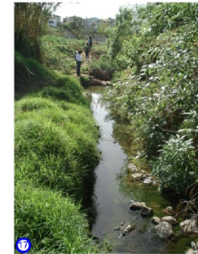
17 Vista para jusante (represamento)
