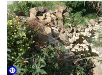
11 Leito - enrocamento do fundo
