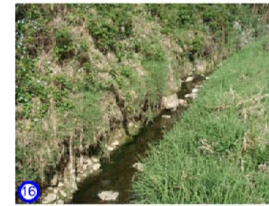
16 Linha de água com banqueta
