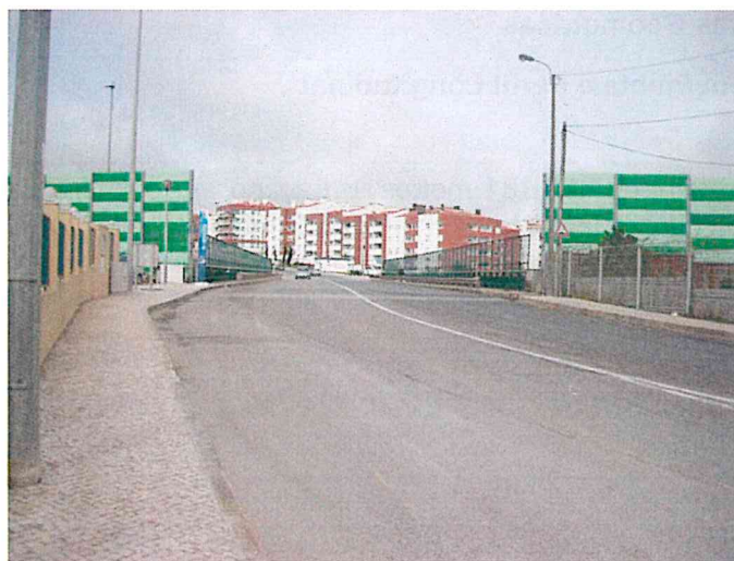
Foto 8 – Eixo 5 na zona da Obra de Arte sobre a A5
