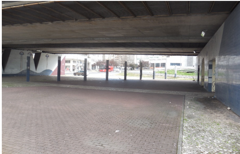
Ponto de amarração do serviço de BRT junto à interface de Sete Rios
