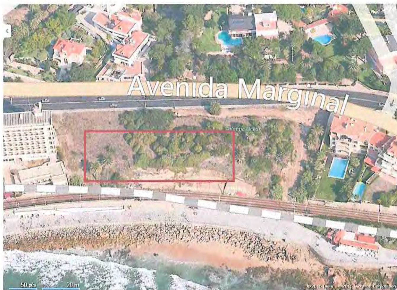
Figura 4. Vista sobre o terreno em causa, onde se pode observar o talude escarpado em parte revestido a betão armado e cortado para a implantação da linha de caminho-de-ferro na sua base. Fonte: Bing Maps.
