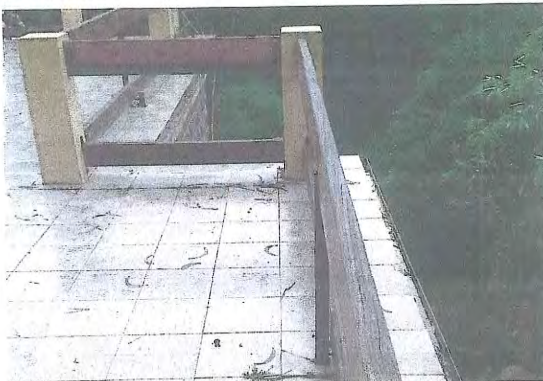
Figura 4: Revestimentos/acabamentos da cobertura
