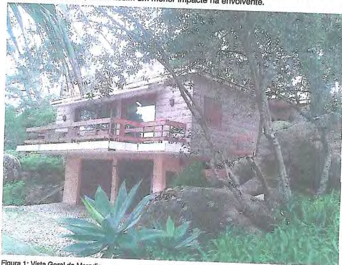
Figura 1: Vista Geral da Moradia
