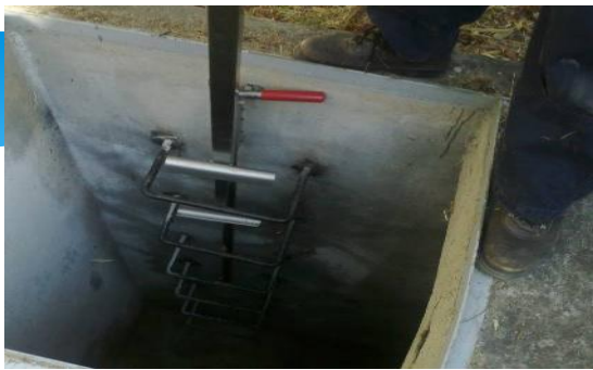
Colocação do dispositivo nos degraus
