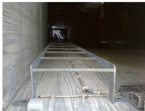
Figura 2 – Caixa com medição de caudal em conduta
