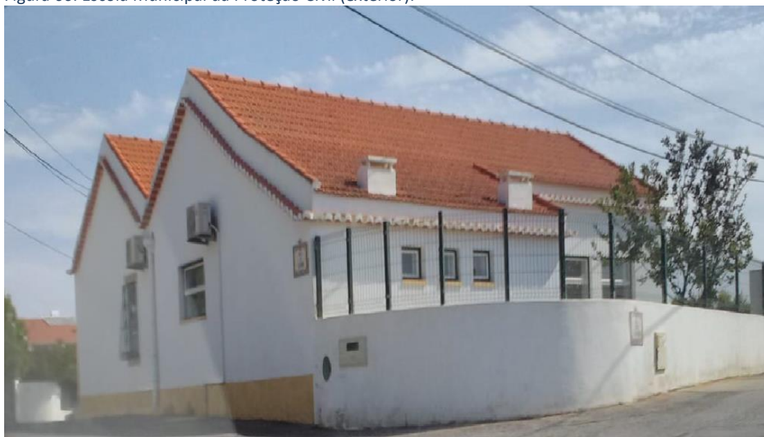
Figura 66. Escola Municipal da Proteção Civil (exterior).
