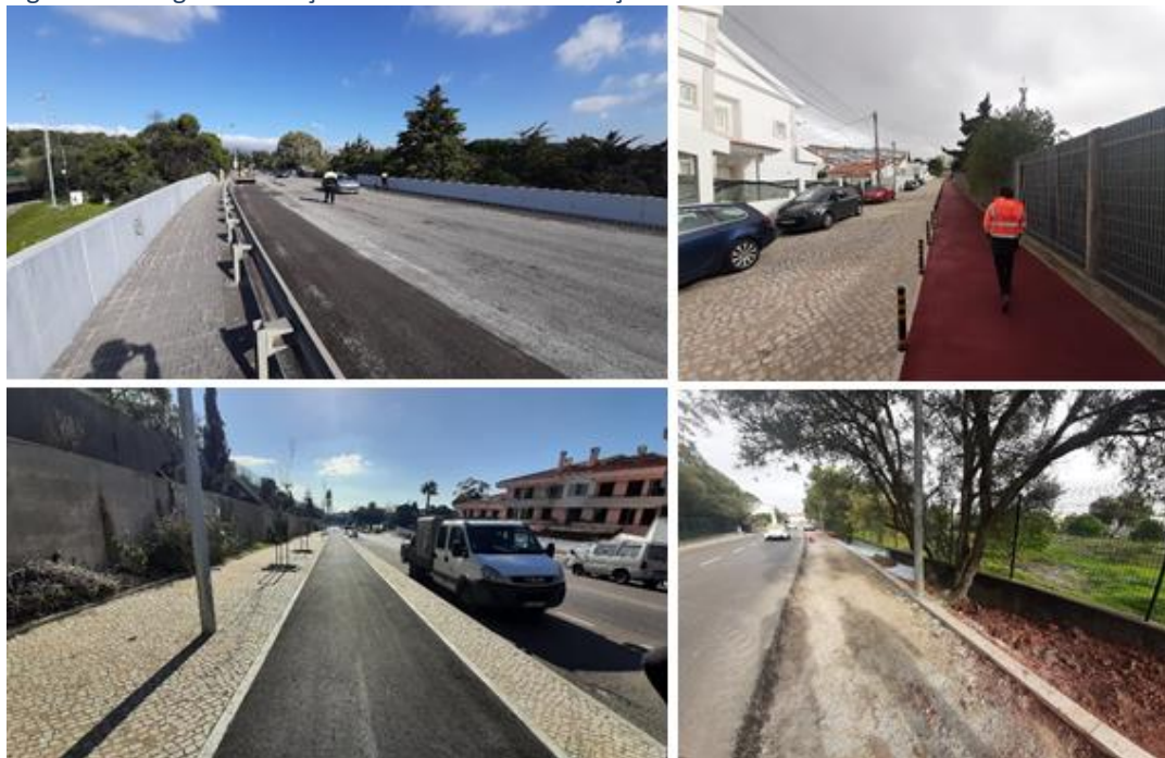
Figura 62. Imagens do troço de ciclovias em construção.
