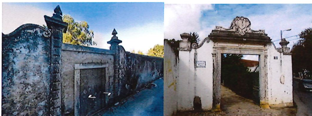
Portal presente na avenida da República e portal maneirista
