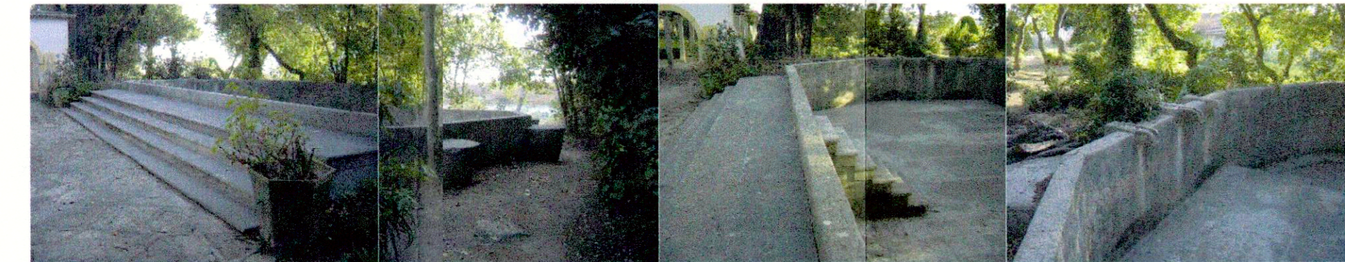
E2_ PÓRTICO EM ALVENARIA (pátio env. ao lago)
