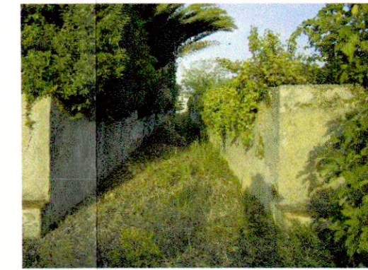
E11_ CAMINHO ENCAIXADO EM MUROS DE ALVENARIA REBOCADA
