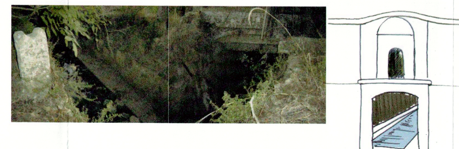
E20_ PONTE ENCOSTADA A MURO LIMITE DA QUINTA, COM A PRESENÇA DE ELEMENTOS CONSTRUÍDOS EM ALVENARIA E PEDRA DE CALCÁRIO
