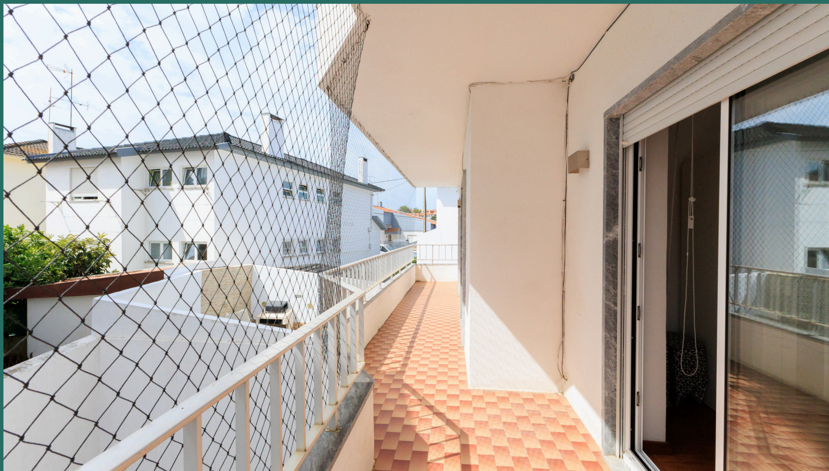
Residência da Torre | Habitação para Docentes
