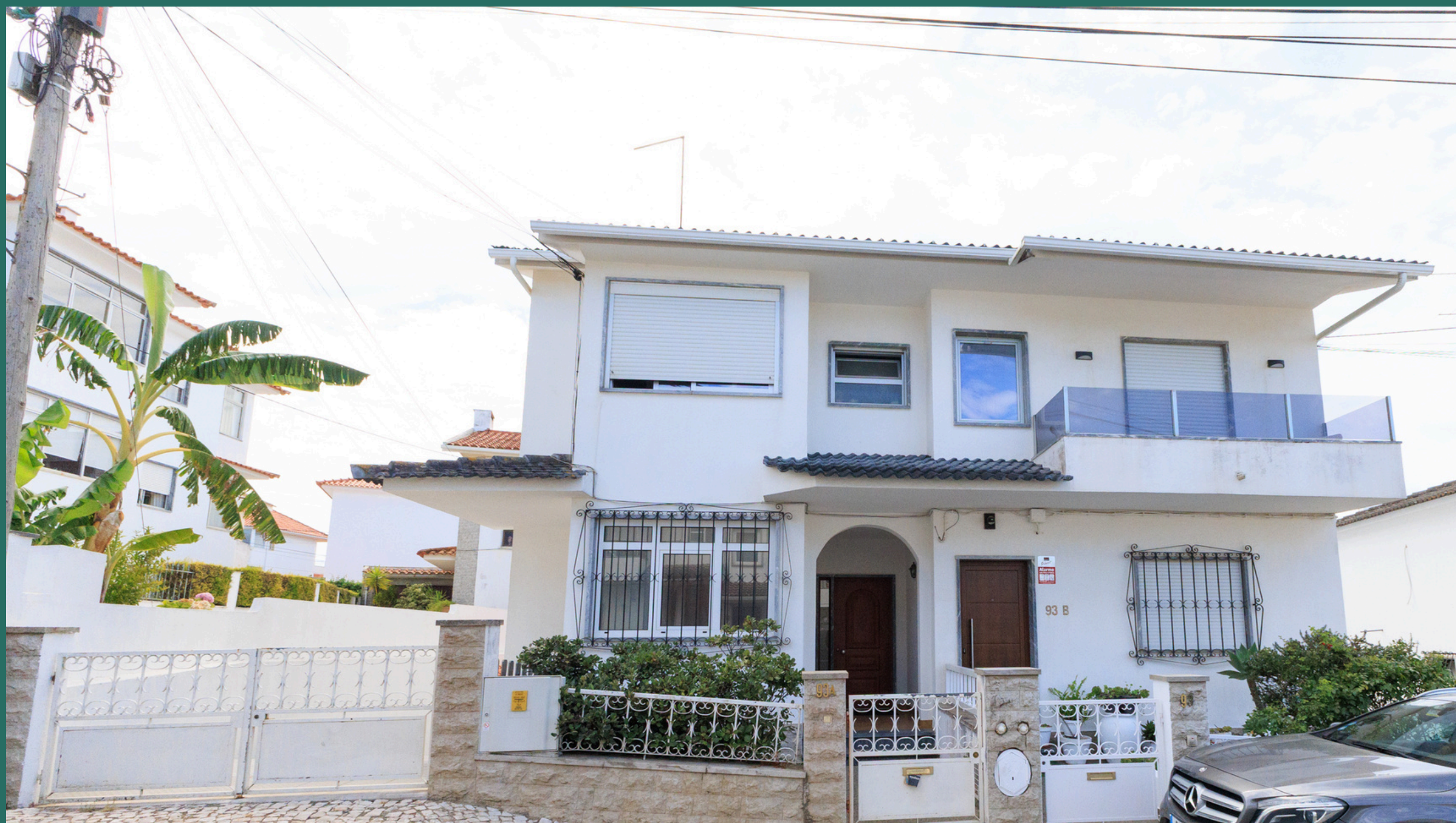
Residência da Torre | Habitação para Docentes
