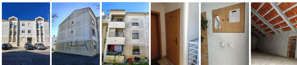
Imagens 9 . Prédio nº85
