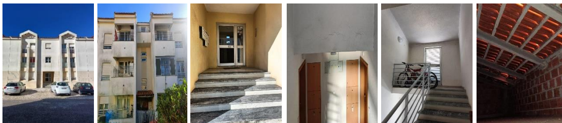
Imagens 3 . Prédio nº67
