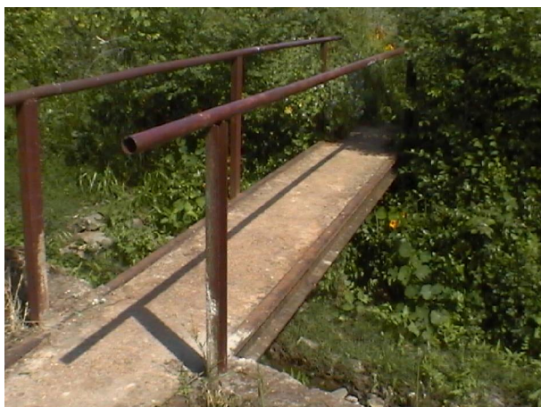
Foto 17 – Pontão sobre o leito principal no Casal do Grilo.
