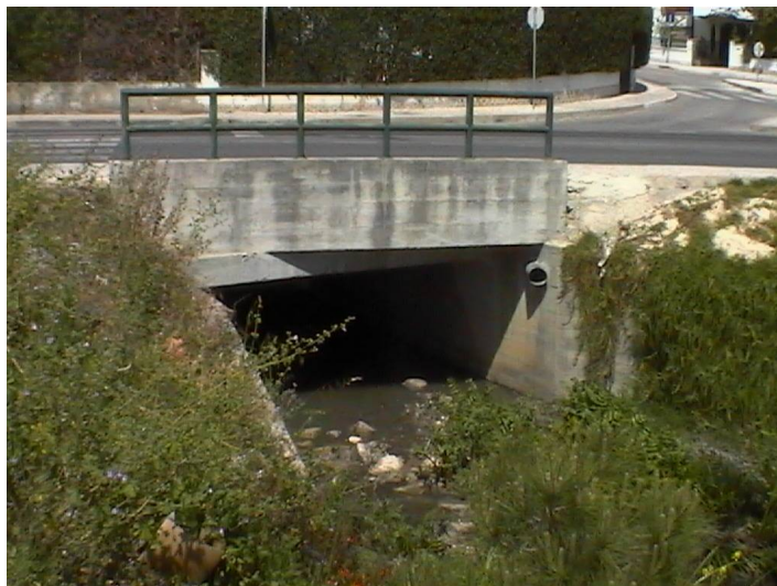
Foto 1-PH da Av. Dr.º Sá Carneiro - vista de Jusante
