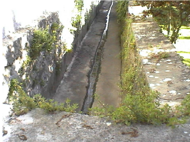
Foto 3 - Canal rectangular de recinto privado
