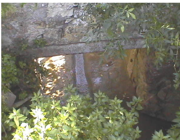
Foto 12 – Muro Norte do Recinto fechado. Barragem frontal ao leito de cheia. Vista de Montante.
