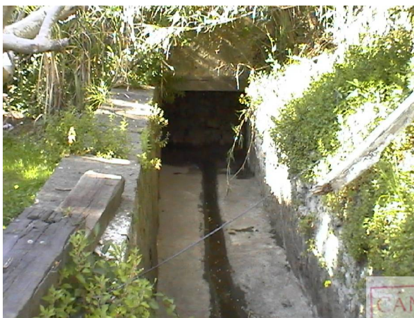
Foto 10- Orifício de entrada no recinto privado, vista de jusante 1,90 x 1,80 ( BxH)
