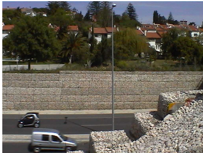
VARIANTE À EN 67 PASSANDO PARALELA, À ESQUERDA A UMA COTA INFERIOR. (CERCA DE -8,0 METROS)
