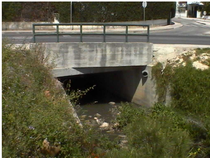
PH DA AV. DR. SÁ CARNEIRO - VISTA DE JUSANTE
