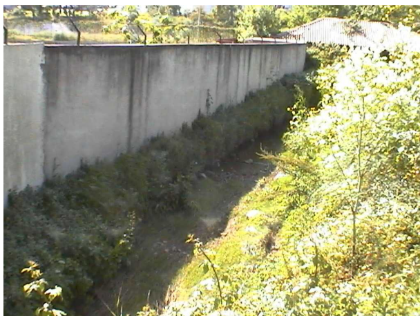
MURO NORTE DO RECINTO FECHADO. BARRAGEM FRONTAL AO LEITO DE CHEIA. VISTA DE MONTANTE.
