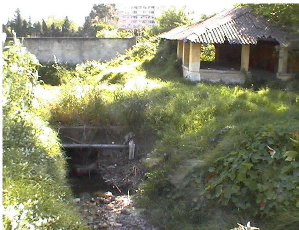
MURO NORTE DO RECINTO FECHADO. VISTA DE MONTANTE NORTE. LAVADOURO. PONTÃO CURVA A 90° DO LEITO PRINCIPAL DA RIBEIRA DE SASSOEIROS.
