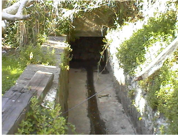
ORIFÍCIO DE ENTRADA NO RECINTO PRIVADO, VISTA DE JUSANTE 1,90 x 1,80 ( BxH)
