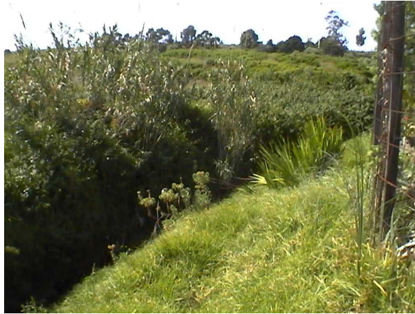
RUA A OLIVEIRA. TROÇO DE FORTE INCLINAÇÃO. VISTA PARA MONTANTE.
