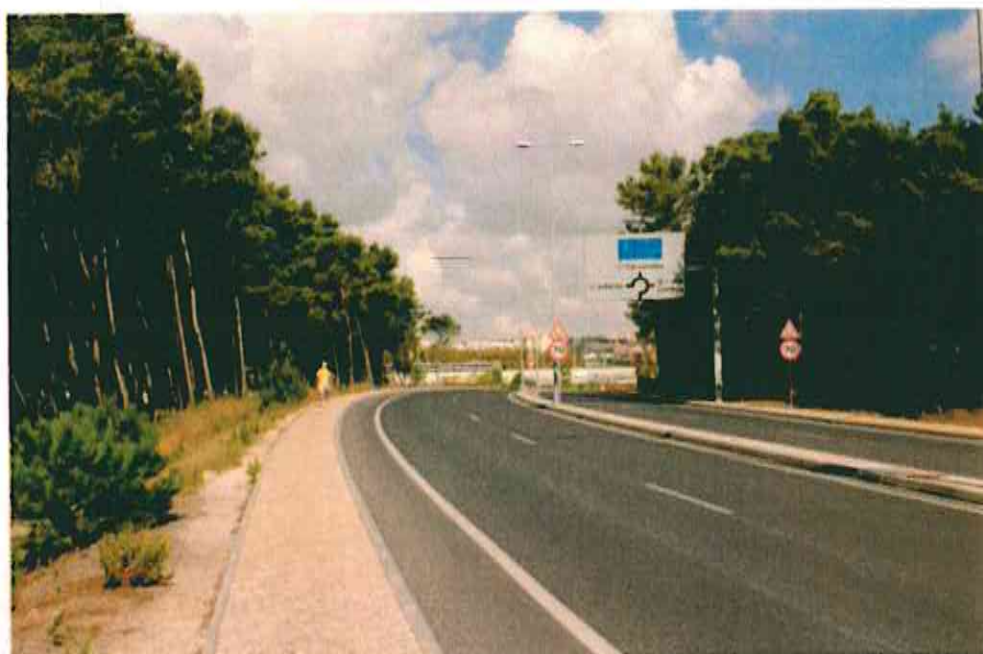
Imagem 9 – Área de localização do passadiço pedonal sobrelevado
