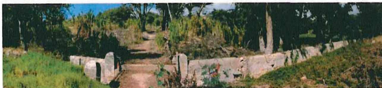
Imagem 8 – Canal hidráulico existente a requalificar
