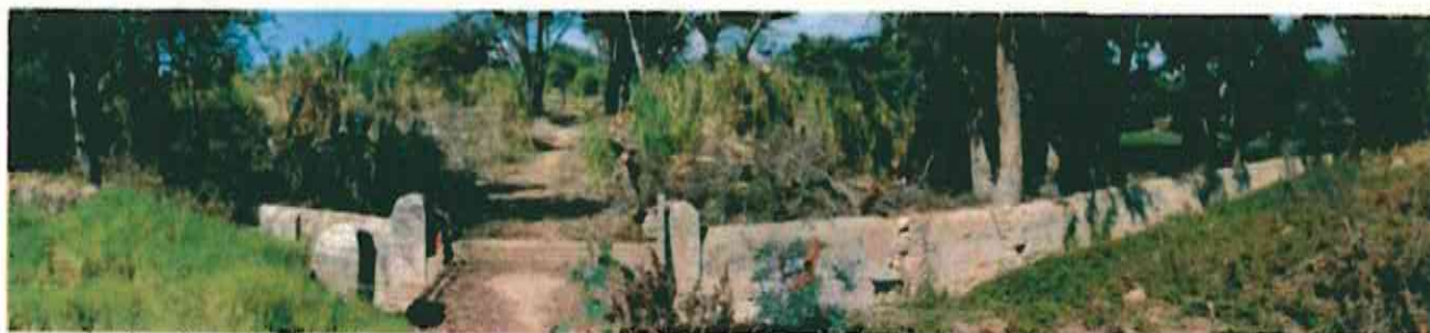
Imagem 8 – Canal hidráulico existente a requalificar
