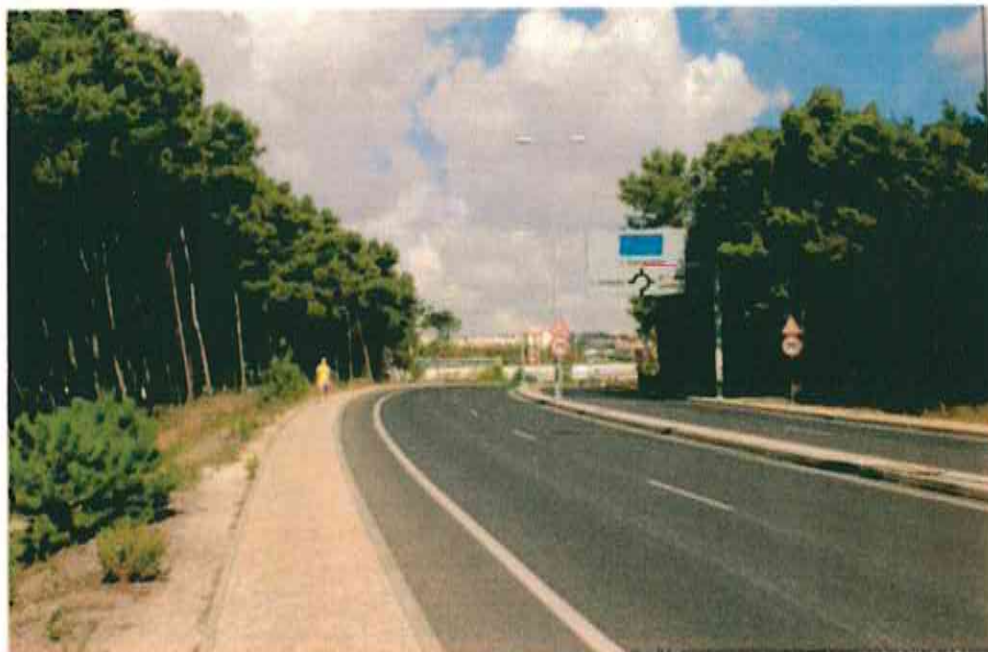
Imagem 9 – Área de localização do passadiço pedonal sobrelevado
