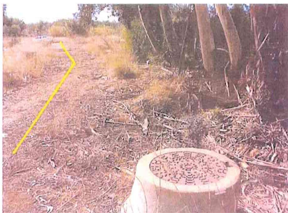
Figura 3 - Câmara de visita do Emissário de Sassoeiros e raminho de acesso (amarelo)
