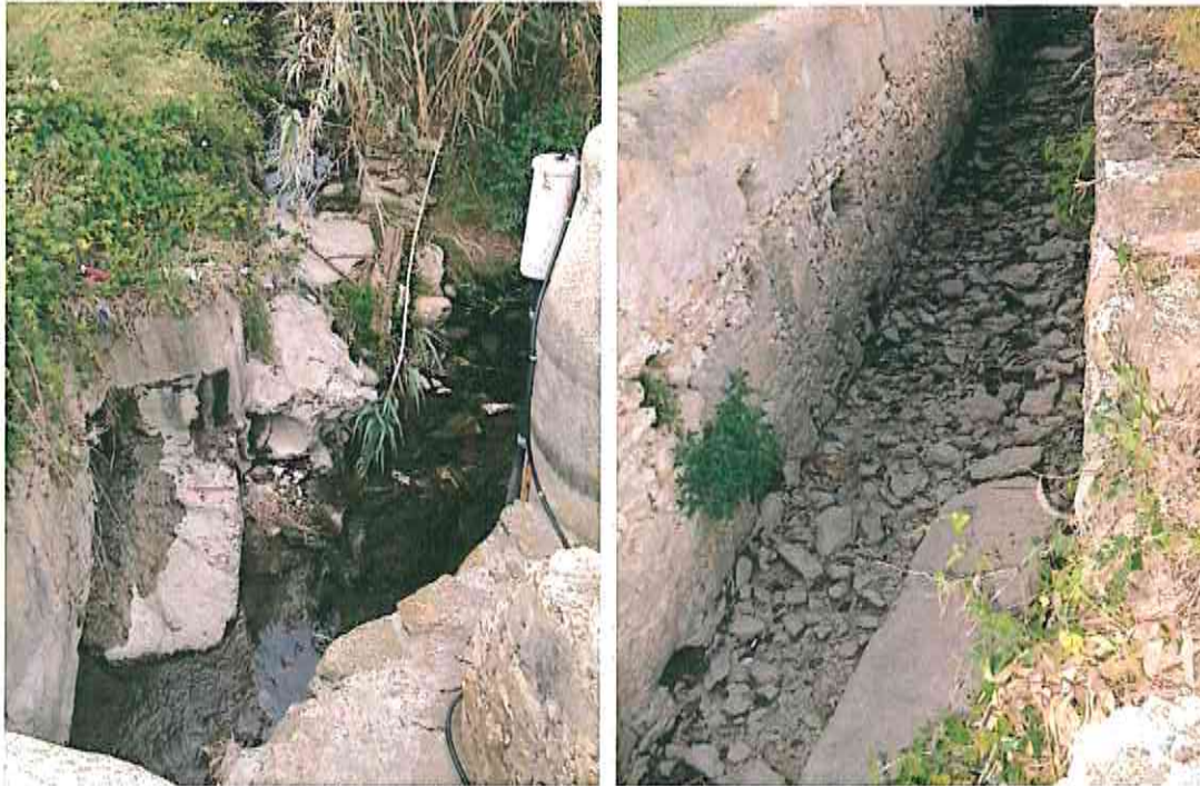
Figura 24 – Ribeira de Sassoeiros canalizada em alvenaria.
