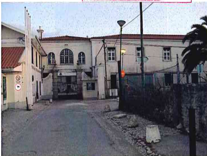
Figura 29 – Entrada do Colégio St. Julian's.
