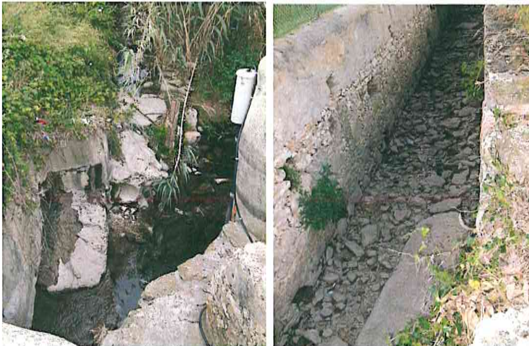
Figura 16 – Troço final da Ribeira de Sasseiros canalizado em alvenaria.
