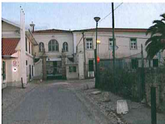
Figura 20 – Entrada do Colégio St. Julian's.
