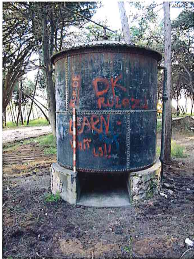
Foto 9- Depósito de combustível localizado no sector V.
