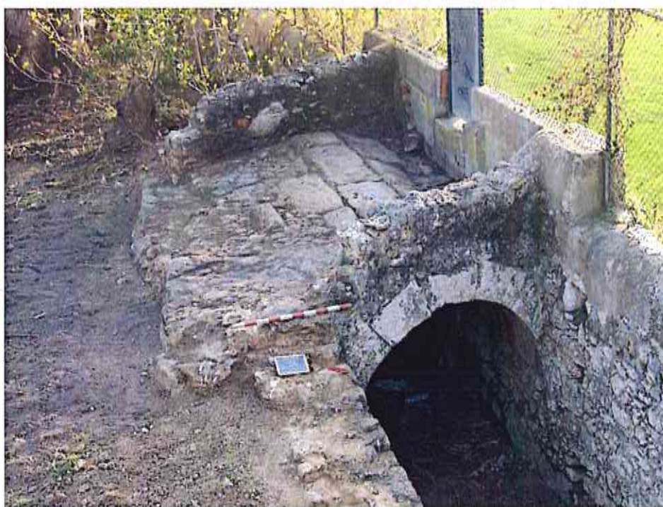
Foto 6 - Aspecto da ponte sobre a ribeira, localizada junto dos campos de futebol.
