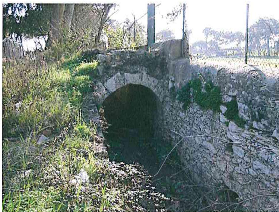
Foto 4 – Aspecto da ponte sobre a ribeira, localizada junto dos campos de futebol, antes dos trabalhos de desmatção e limpeza.
