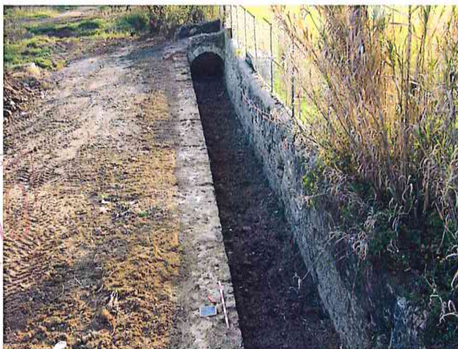
Foto 5 – Aspecto da ponte sobre a ribeira, localizada junto dos campos de futebol, depois dos trabalhos de desmatamento e limpeza.
