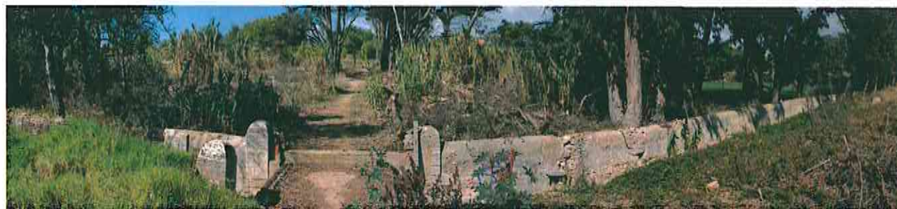
Imagem 8 – Canal hidráulico existente a requalificar
