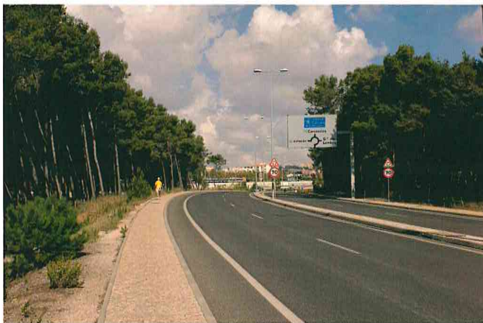
Imagem 9 – Área de localização do passadiço pedonal sobrelevado
