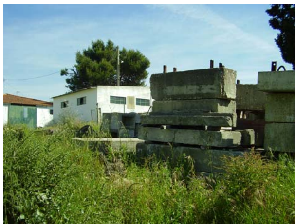
Figura 5.3.21 – Materiais de construção (pilha de blocos de betão) deixados na área de intervenção do PPETSN
