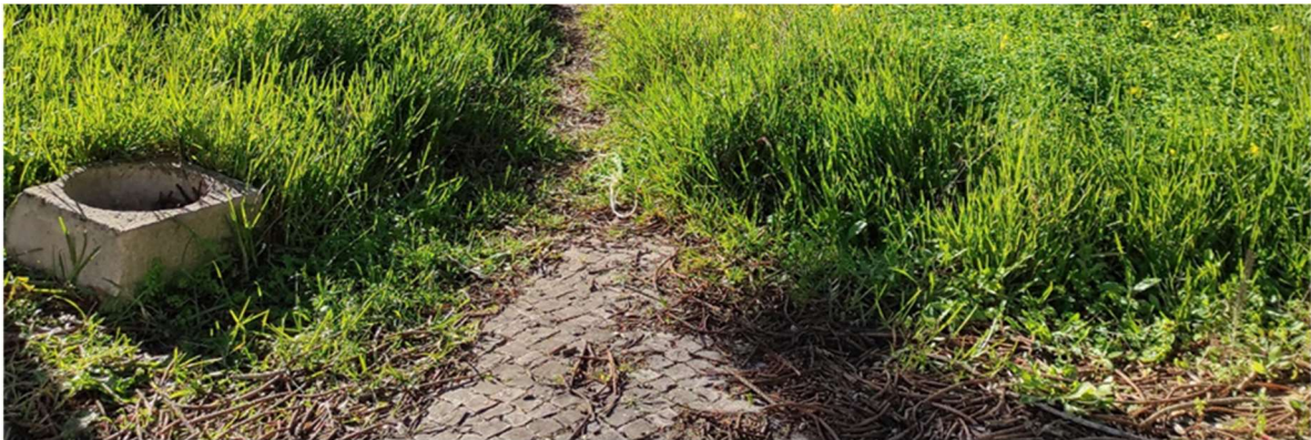
Foto 14: Vestígios dos pavimentos de calçada do jardim
