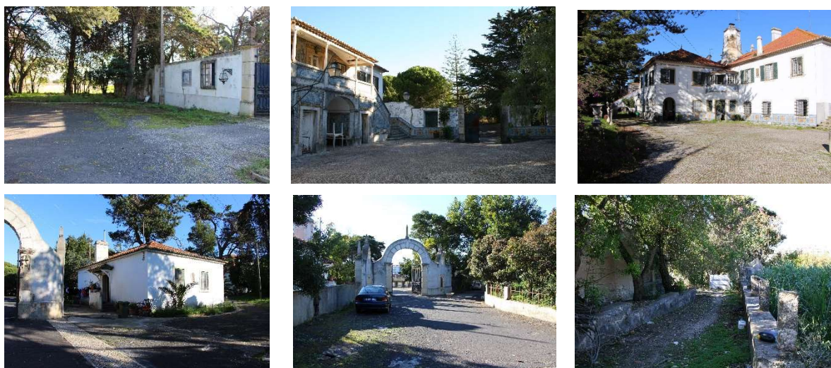
Fotos 33: Circulação interna na Quinta do Barão
