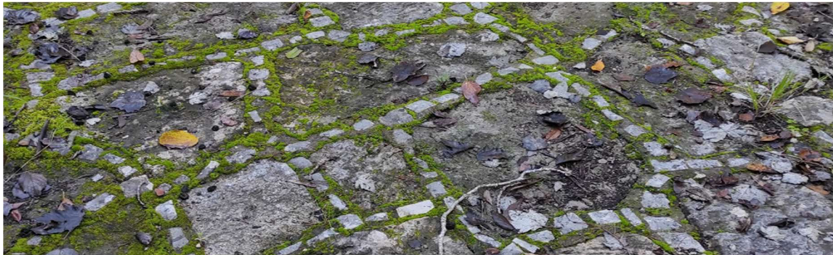
Foto 15: Pavimentos de calçada e cascão da antecâmara da piscina
