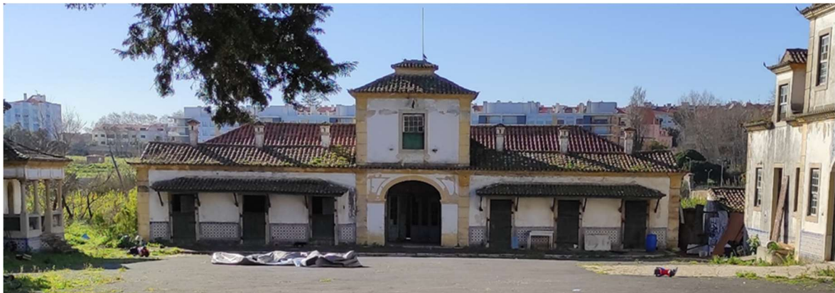
Foto 13: Pavimentos do núcleo de serviços em alcatrão e calçada
