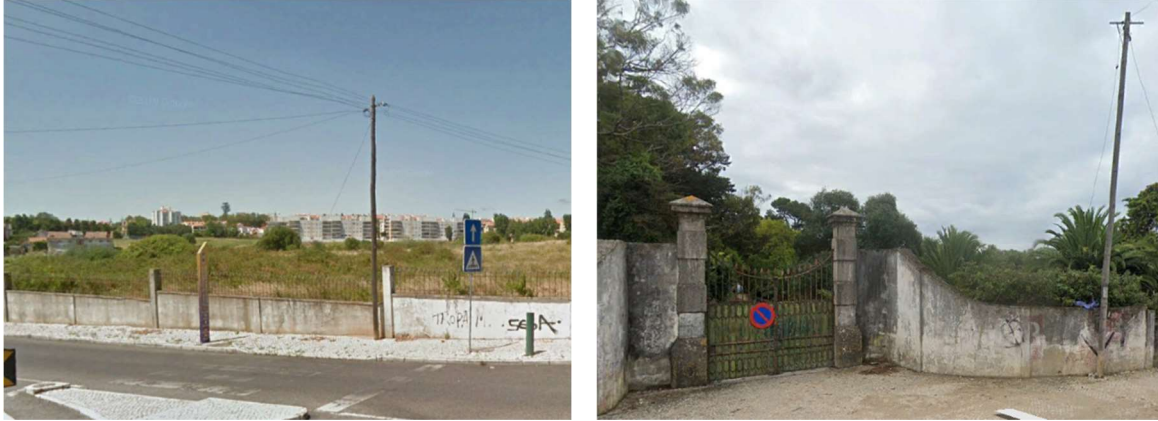
Fotos 36: Redes aéreas de telecomunicações na proximidade da AI do PP
