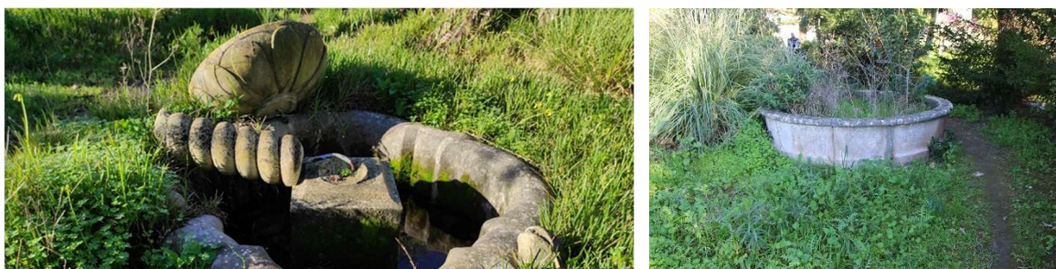
Foto 19: Tanques do jardim em avançado estado de degradação
