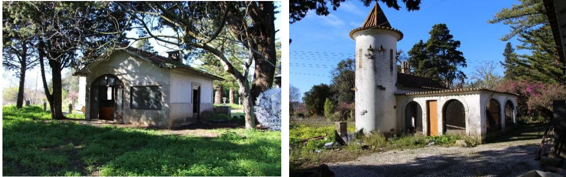
Foto 1: Imóveis que deveriam estar integrados no conjunto classificado
