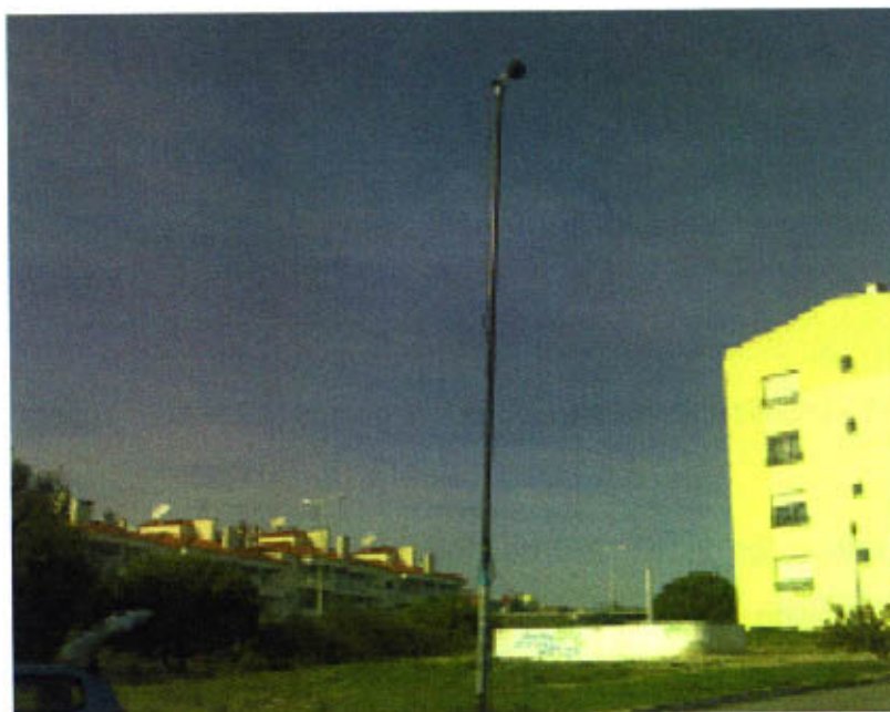
Figura 4.27 – Pormenor do ponto de medição sonora 2 (P2), junto à extremidade Sul da urbanização da Encosta dos Gafanhotos
