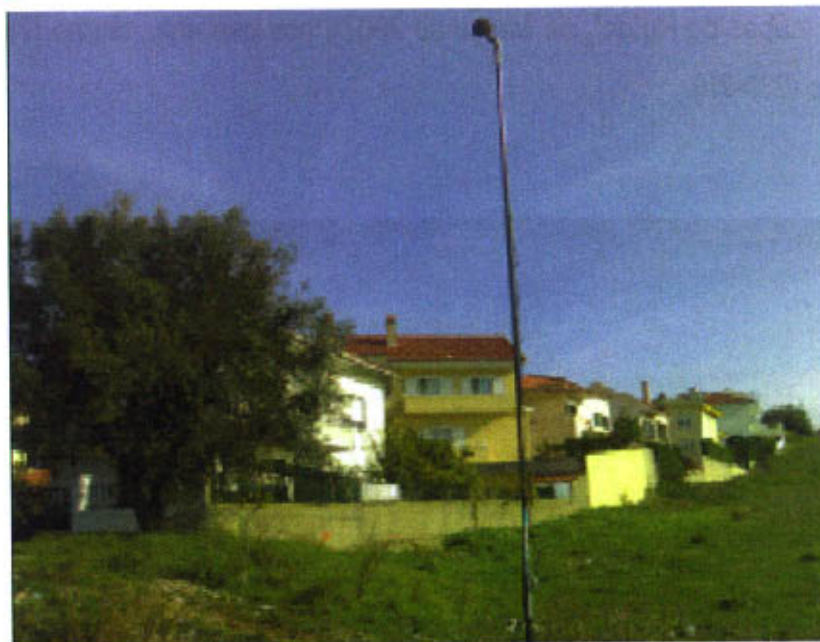
Figura 4.26 – Pormenor do ponto de medição sonora 1 (P1), junto à urbanização do Arneiro
