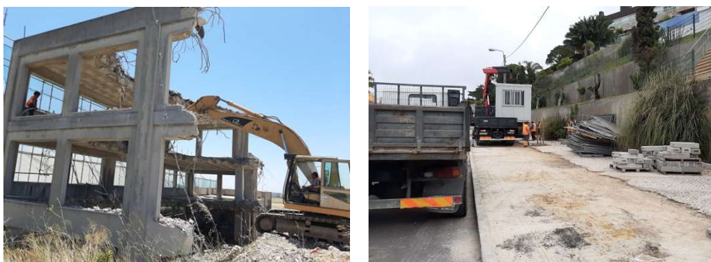
Figura 5 - Demolição Edifício Vega e Ciclovia Av. da República (Estoril)
