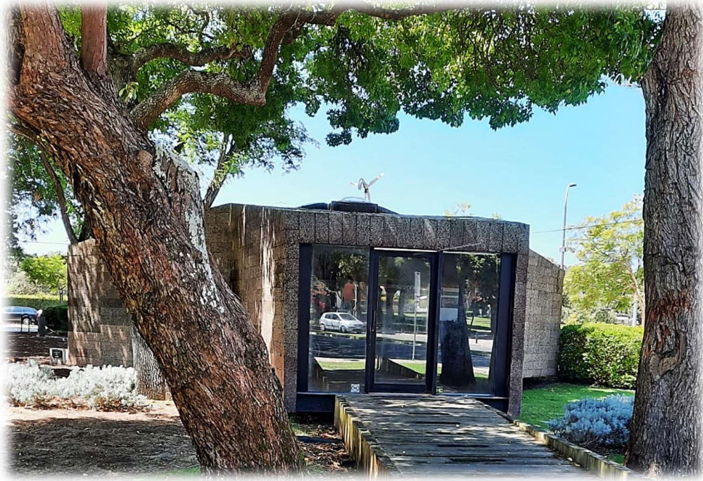
Figura 13 - Obras de reparação e manutenção no quiosque da Ecocabana
