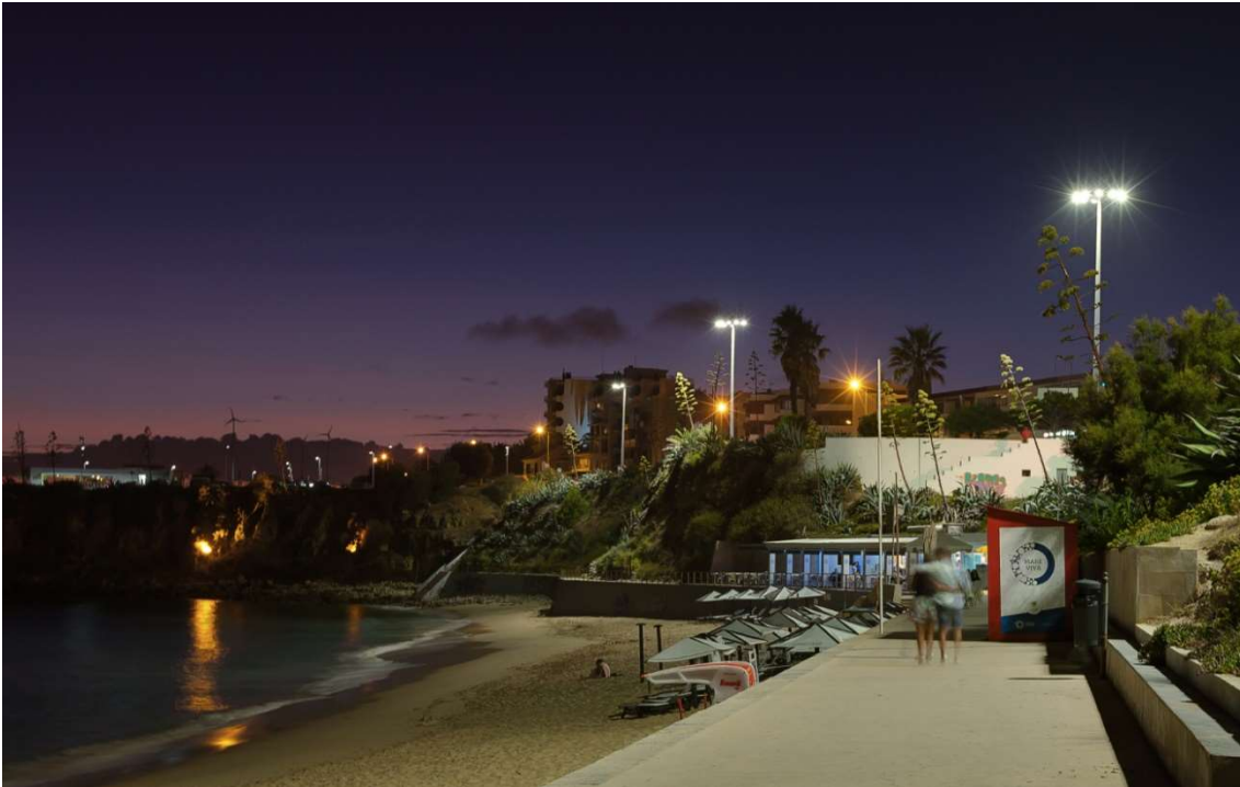
Figura 18 - Manutenção e reparação de iluminação e infraestruturas elétricas na orla costeira
