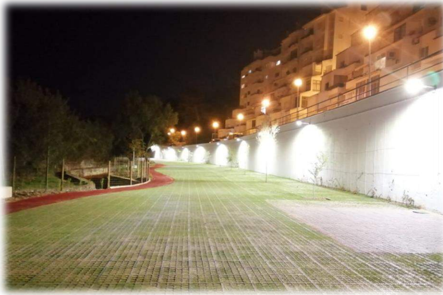
Figura 15 - Infraestrutura elétrica do parque de estacionamento da Ribeira das Vinhas
