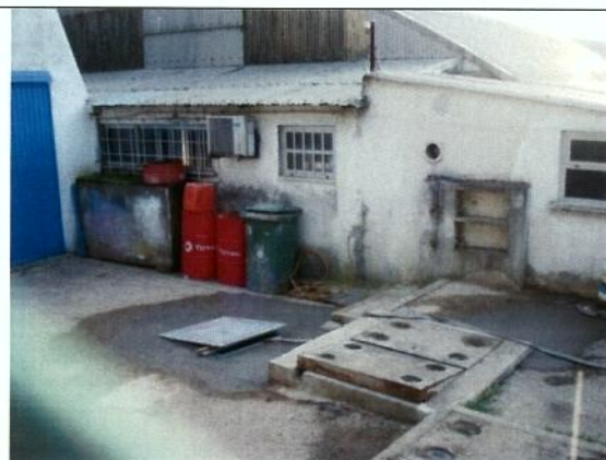
Caixa de drenagem
