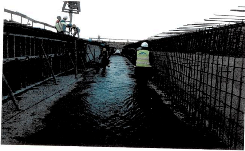
Imagem 4 – Cobertura da Ribeira
