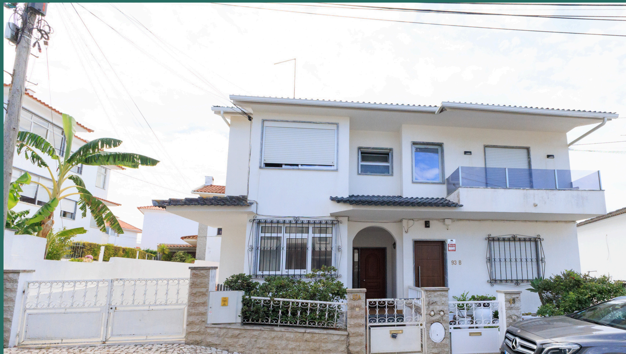
Residência da Torre | Habitação para Docentes
