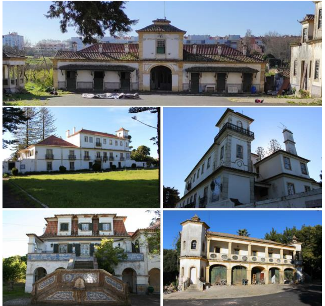
Figura 16 – Perspetiva exterior de algum do edificado histórico da Quinta do Barão (NRV, 2021a)
