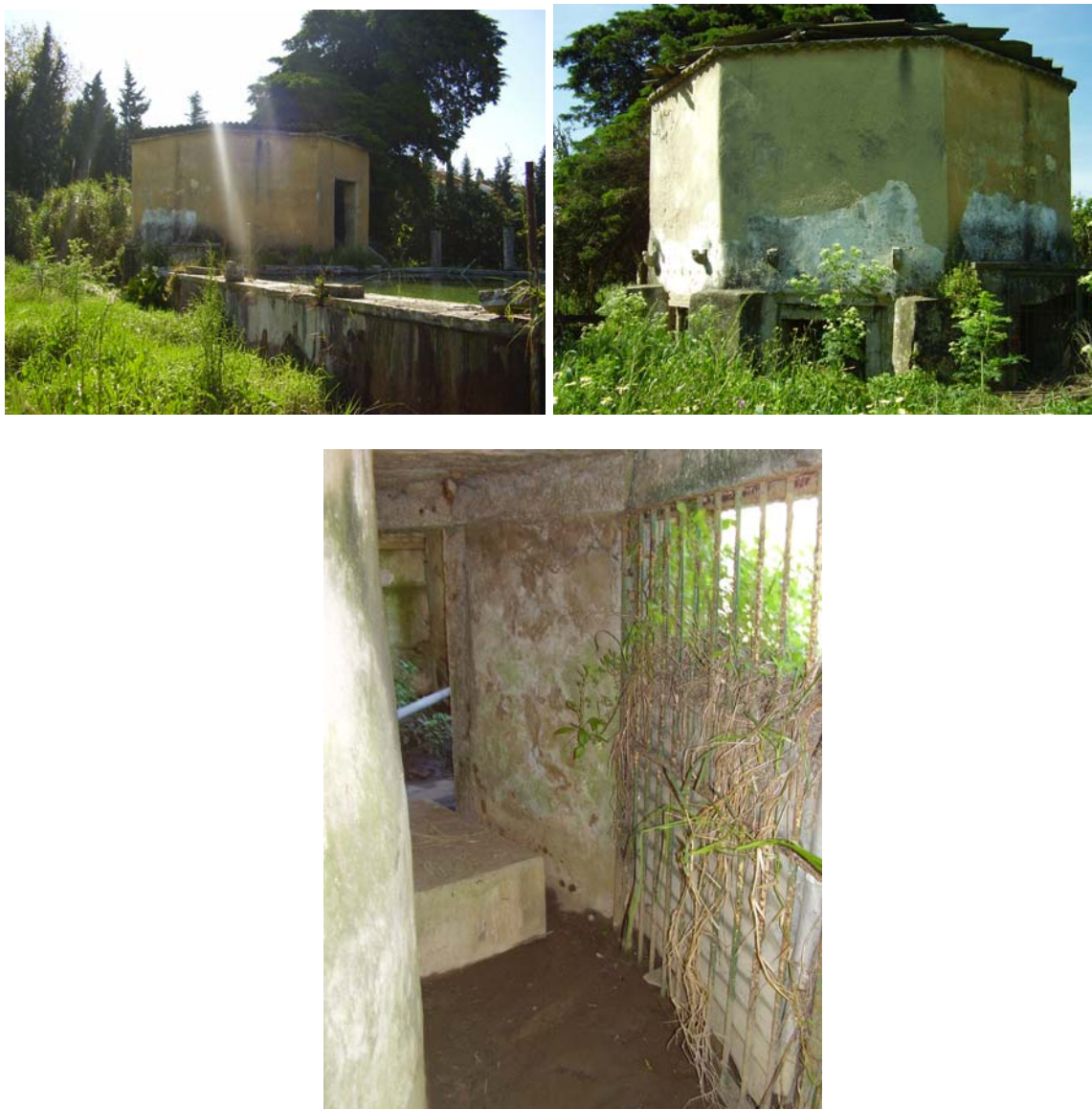
Figura 5.3.3 – Poço com tanque adossado existente na parte sul da área de intervenção do PPETSN
