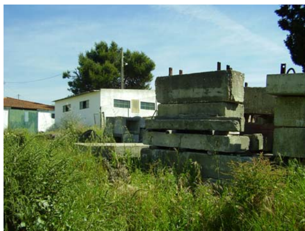
Figura 5.3.21 – Materiais de construção (pilha de blocos de betão) deixados na área de intervenção do PPETSN
