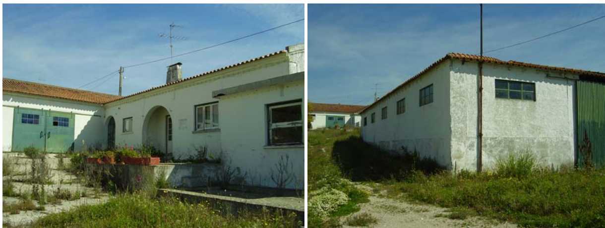
Figura 5.3.20 – Edifícios (armazéns e casa do guarda) existentes e a demolir na área de intervenção do PPETSN
