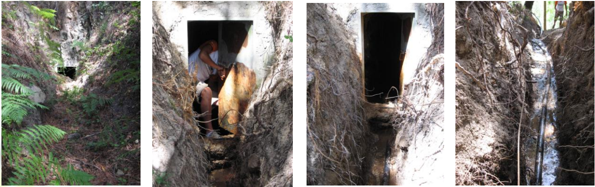
Figuras 18 a 23. Diversas etapas dos trabalhos de limpeza da mina adjacente à Fonte.
