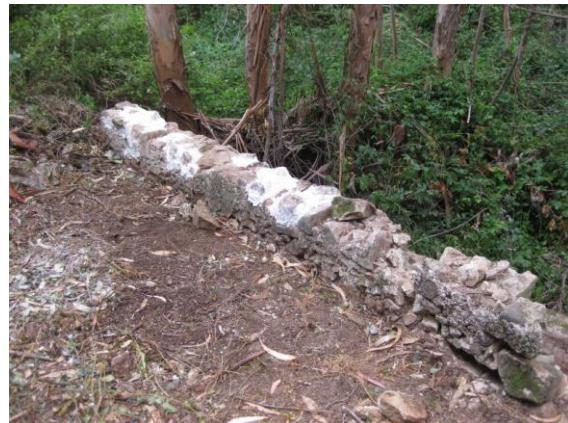
Figura 11 e 12. Limpeza de vegetação antes da consolidação de alvenaria num trecho (1m) do aqueduto adjacente ao tanque.
