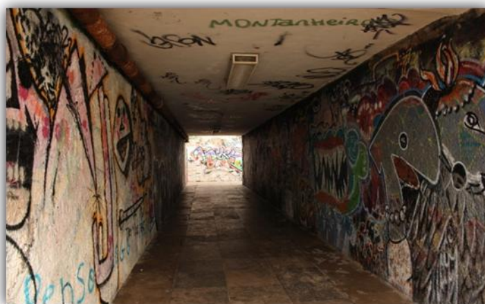
Figura 42 – Aspecto actual do túnel das Avenças.
