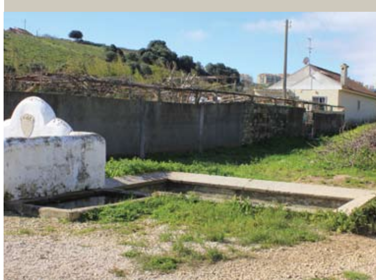
FONTE E BEBEDOURO DE FREIRIA
