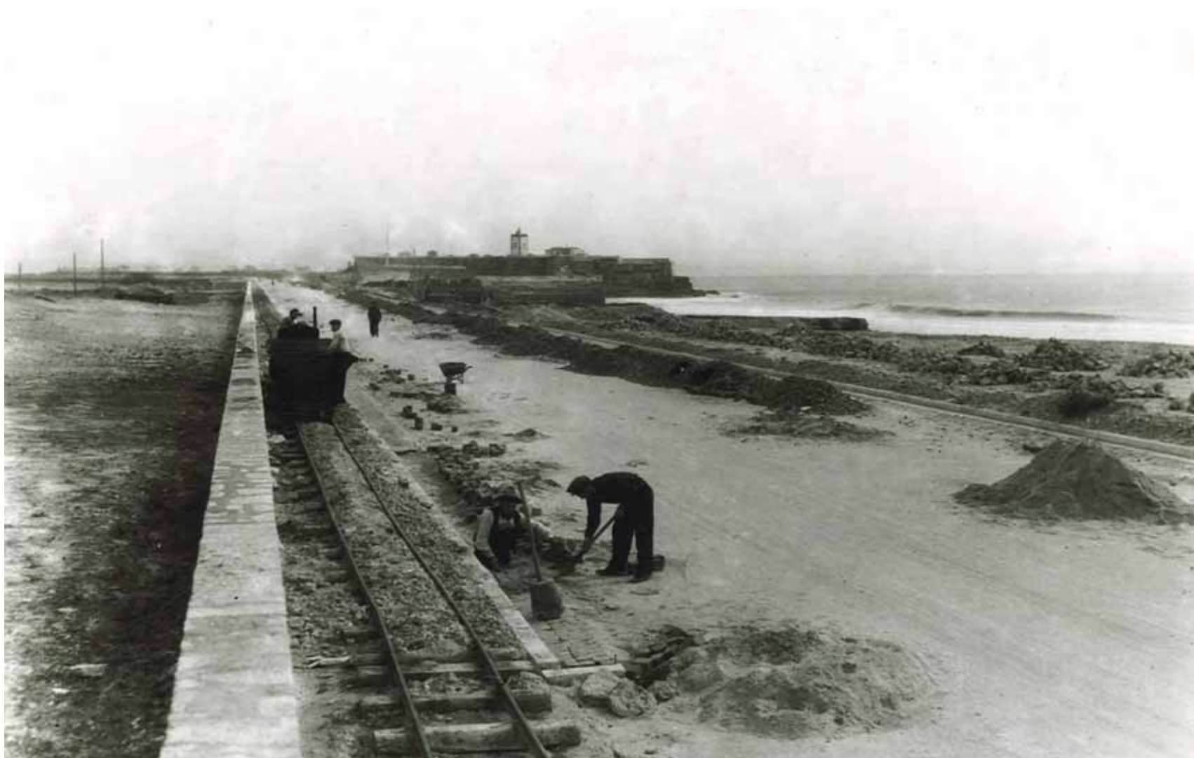
Construção da Estrada Marginal, em Carcavelos, d. 1940 AHMCSC/AFTG/CAM/B/048
