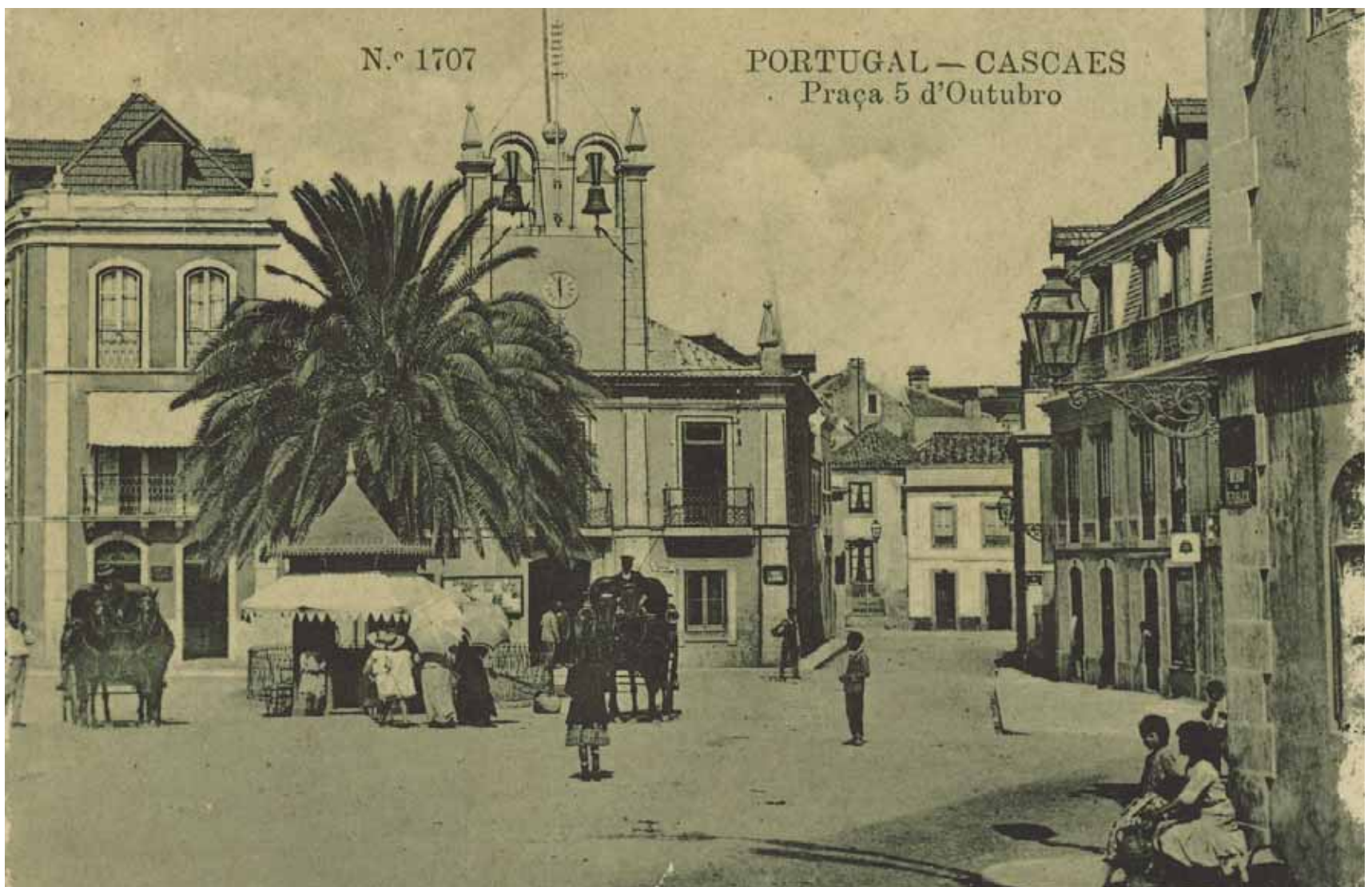
Antigos Paços do Concelho, concluídos em 1822 AHMCSC/AESP/CMES/096
