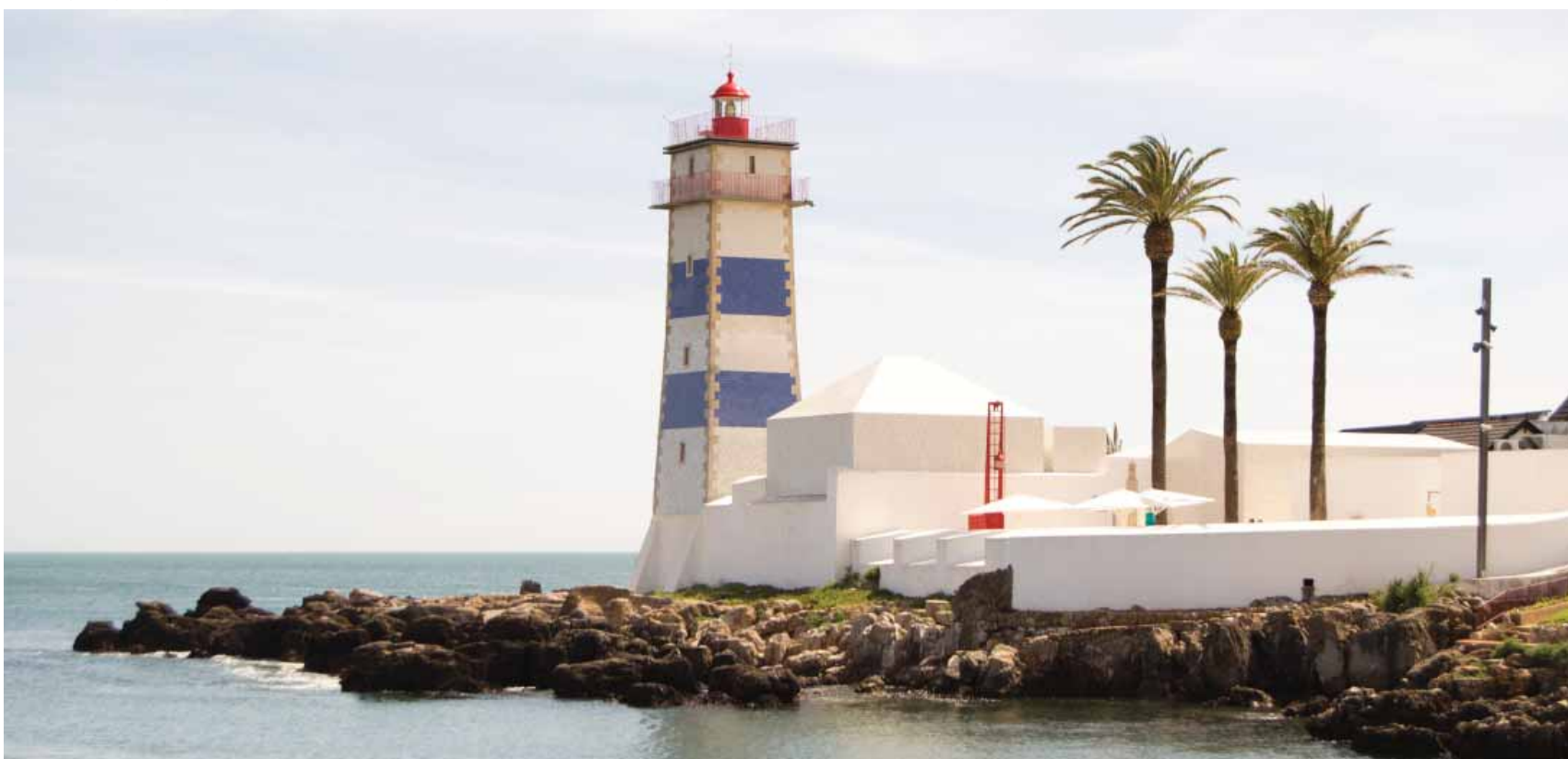
Forte e Farol de Santa Marta na atualidade, após intervenção de reabilitação e musealização
